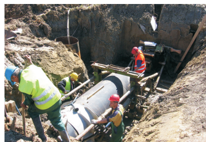
Lucrări de subtraversare drum pentru conducta de aducțiune
