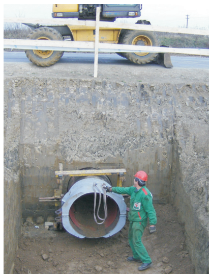
Lucrări de subtraversare drum pentru conducta de aducțiune
