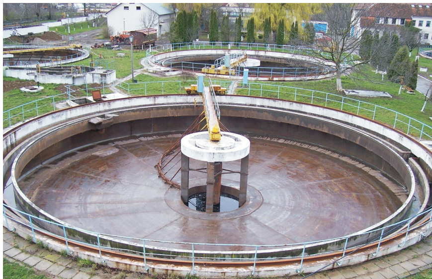
Stația de epurare: decantare primare golite, aflate în curs de curățare și demontare a echipamentelor
