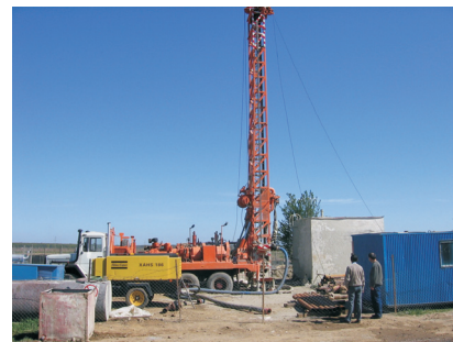
Lucrări de reforare la un puț de captare a apei
